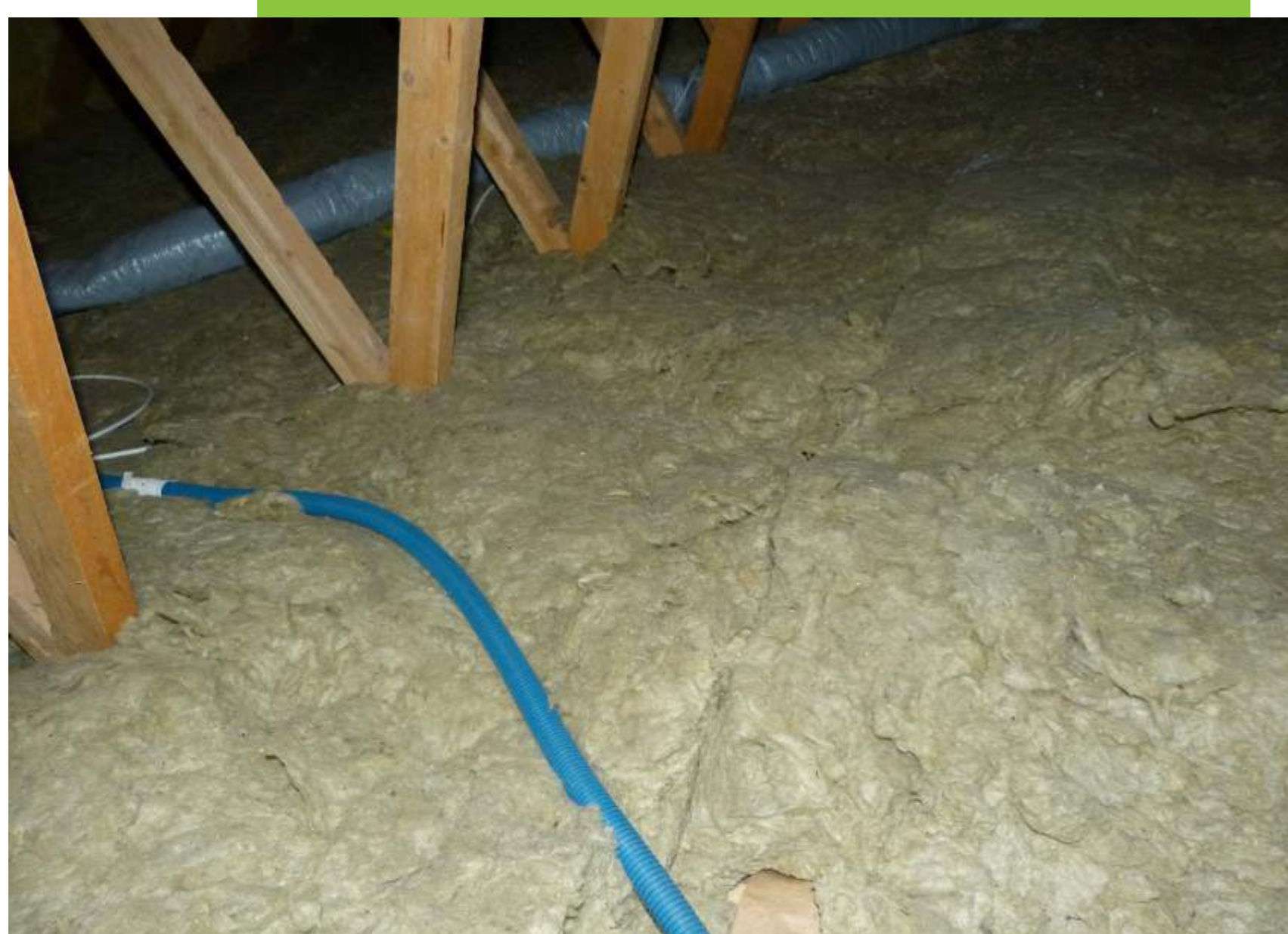
Laine de roche déroulée entre fermettes
