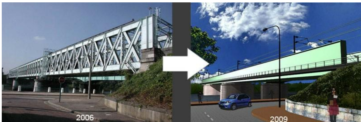
Changement de pont métallique à Oissel
