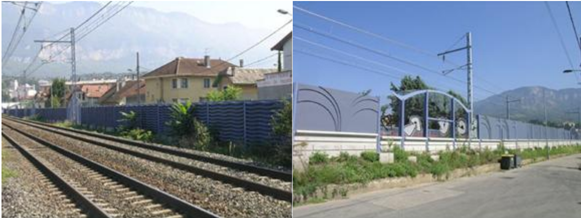
Exemples d'écrans acoustiques à Aix-les-Bains
