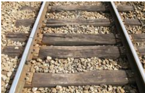
Rails courts sur traverses bois
