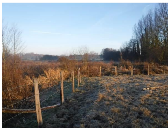
Installation de clôtures sur le Gandelin
