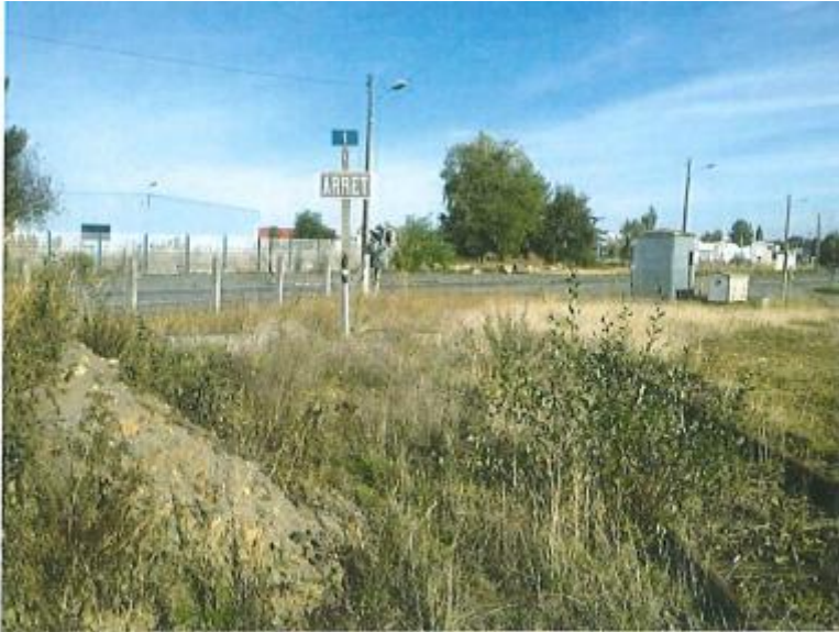
Suppression du Passage à niveau n°1 – Avenue Pierre Piffault au Mans
