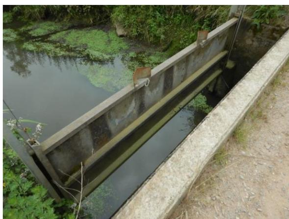
Le maintien de la vanne ouverte permet de rétablir la continuité écologique et de visualiser la réaction du cours d'eau. Ces opérations seront généralement accompagnées par des travaux de type radier en amont sur le lit du cours d'eau pour assurer des ralentissements ponctuels du régime.
