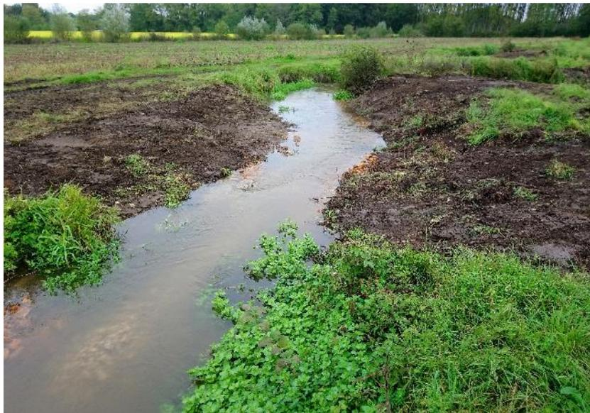
Restauration des berges et du lit par atterrissement sur banquettes de granulats et resserrement du lit mineur
