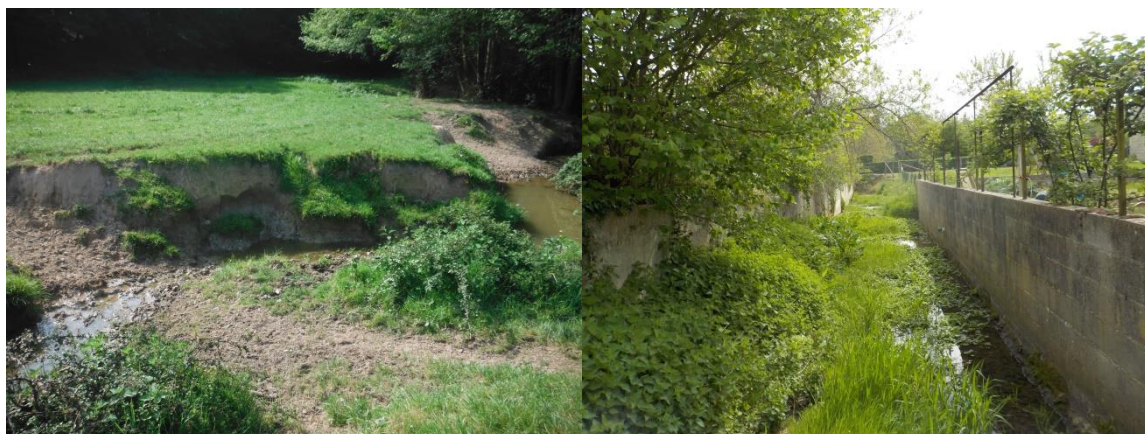
Figure 110 : Situations dégradées - Source : Hardy Environnement
