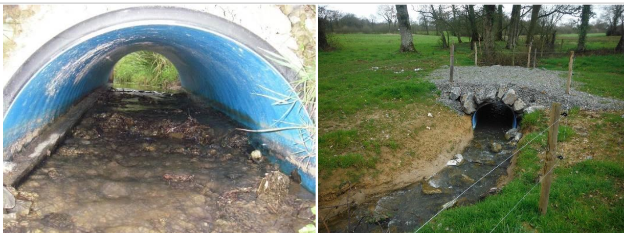
Buses remplacées – Source : Hardy Environnement
