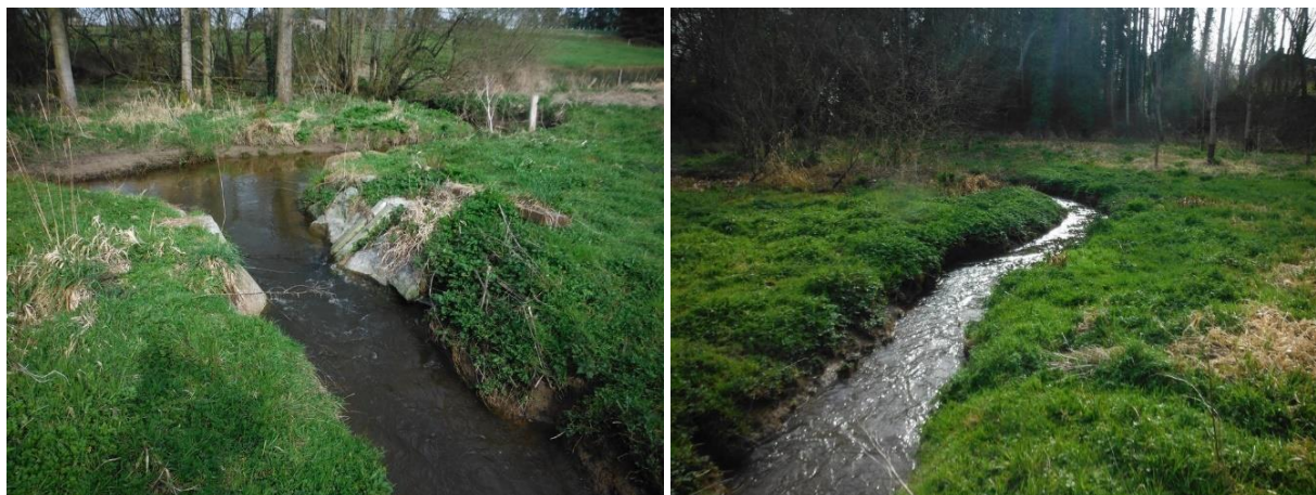
Ouvrage de répartition avec remise en fond de vallée partielle du cours d'eau – Source : Hardy Environnement
