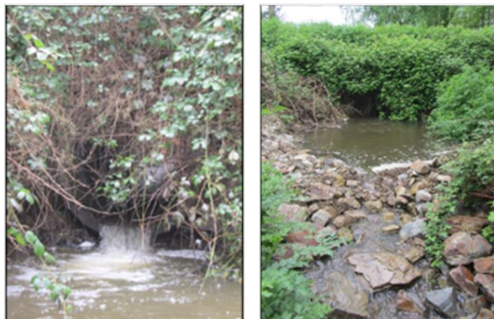
Aménagement d'une rampe d'enrochement – Source : Hardy Environnement
