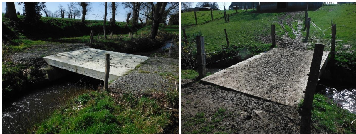
Passerelles en béton aménagées sur le bassin versant du Couesnon aval – Source : Hardy Environnement
