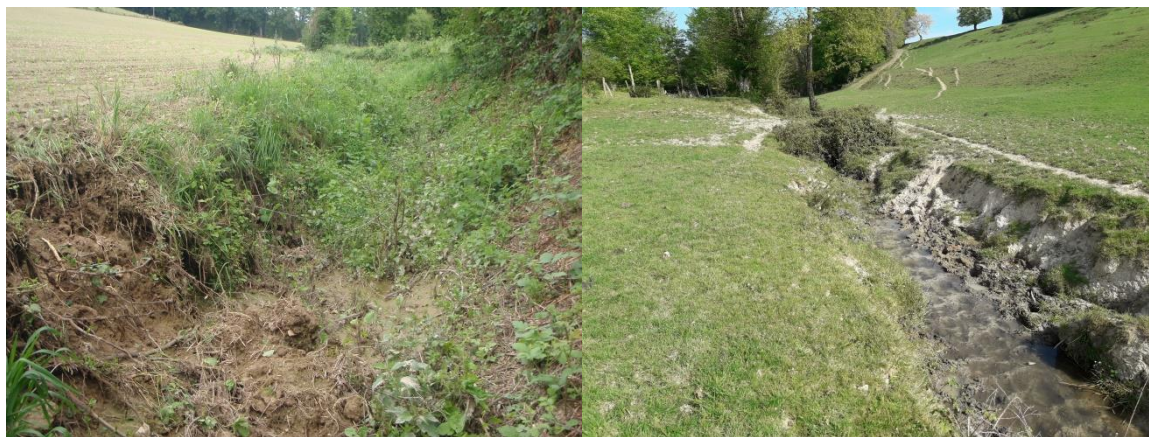
Figure 108 : Situations dégradées - Source : Hardy Environnement
