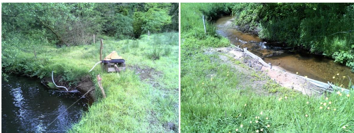
Pompe à museau installée et berge restaurée sur le bassin versant du Trévelo – Source : Hardy Environnement
