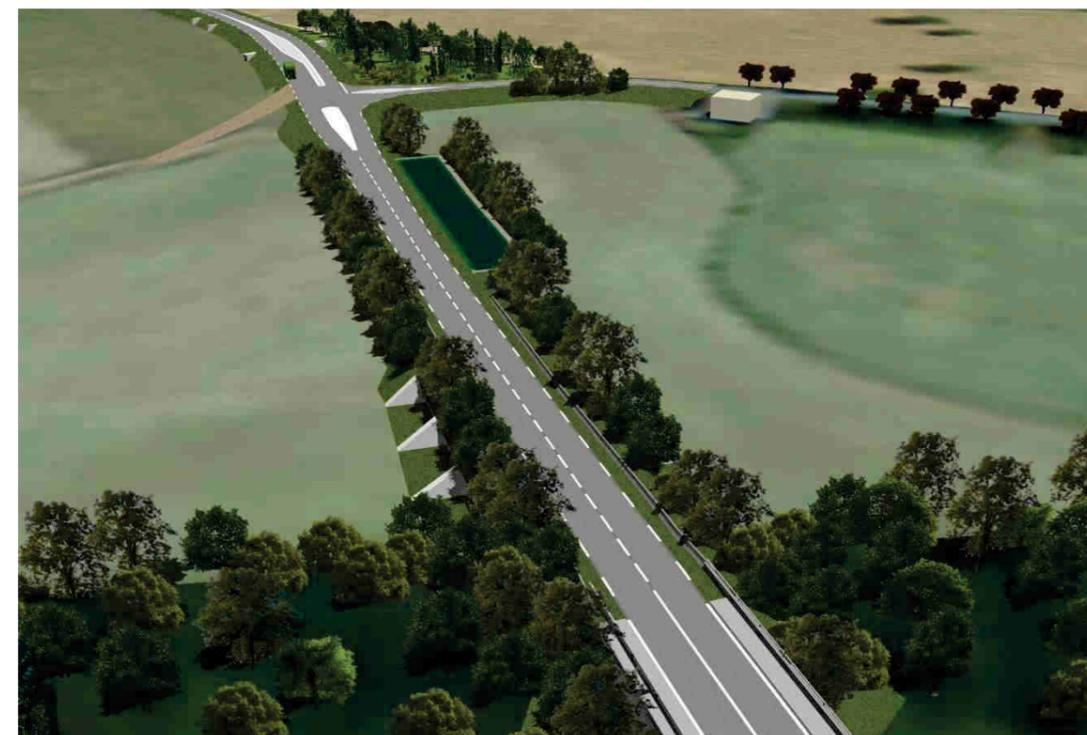
Illustration 55 : Les remblais et l'ouvrage hydraulique de cette portion neuve sont intégrés par des plantations
