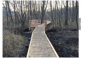
Un exemple de cheminement en bois pour traverser les zones humides. (Photo: M. Malassigné)
