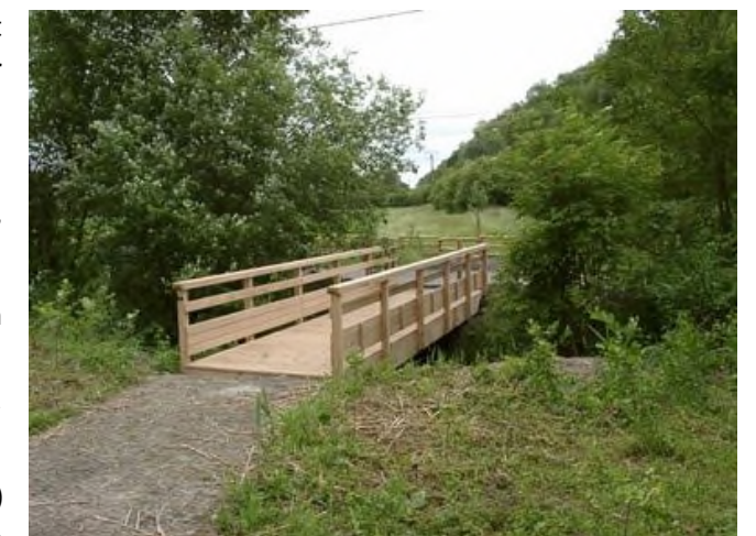
Figure 41 - Passerelle bois autoportée
