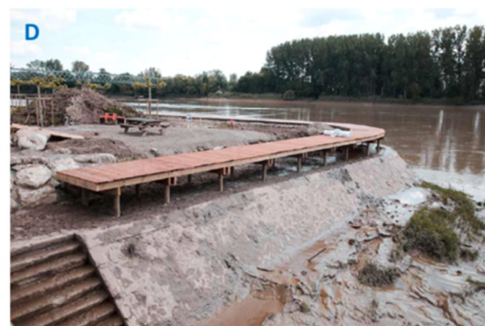
Figure 35 - Etapes de construction d'un cheminement sur pieux battus de 450 m.l. sur les quais de la Garonne à Langoiran
