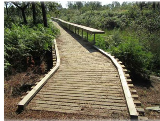
Figure 6 - Passerelle en platelage bois à Saint-Paul-lès-Dax
