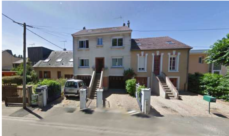
Figure 69 : Exemple de 4 maisons mitoyennes en zone inondable à Coulaines (rue Rabelais) – les 2 maisons au centre ont un 1 er niveau habitable sur garage – les autres maisons ont un premier niveau habitable au rez-de-chaussée
